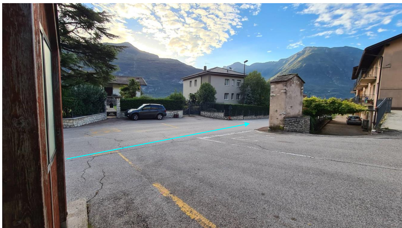
Figura 5.21: Vista da monte della SP90 con indicazione delle linee preferenziali di deflusso in base alla pendenza del terreno, in caso di ostruzione dello scatolare.
