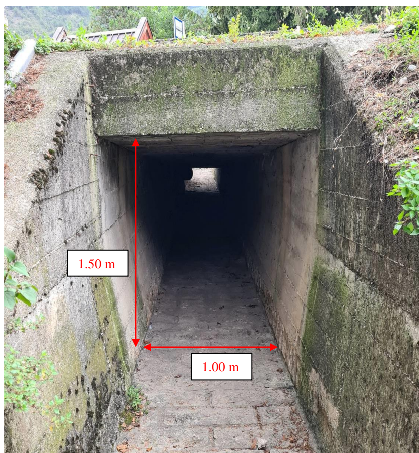
Figura 5.10: Imbocco di valle dello scatolare di attraversamento della SP90 in loc. Capitelli a Pilcante.
