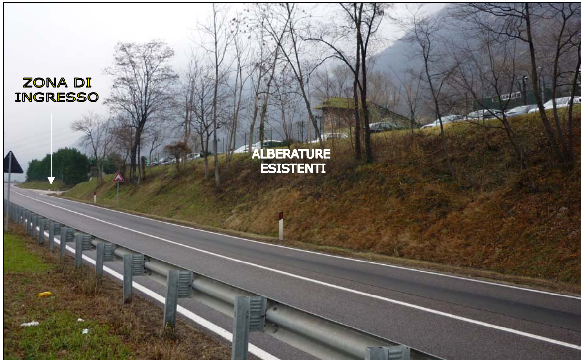
foto n.10: vista dal lato Sud della SS n.12
