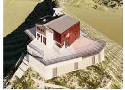
Il secondo obiettivo è stato riqualificare e risanare le facciate e la copertura esistenti (compresa quella piana), riducendo al minimo le demolizioni delle strutture esistenti, rivestendo l'involucro con un nuovo cappotto termico protetto dalle intemperie e dalla grandine con una lastra cementizia rasata / intonacata a finitura rustica (simil esistente), utilizzando un idoneo prodotto ad alta traspirabilità con resistenza meccanica e alle basse temperatura.
